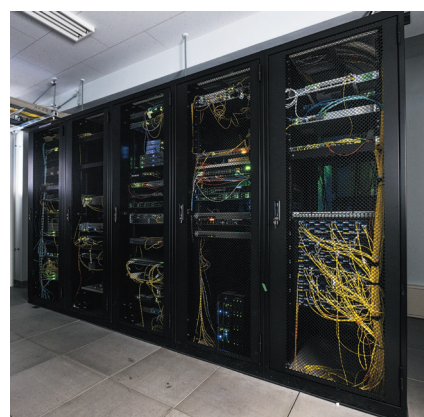
情報基盤センターのネットワーク機材。サーバー類はなく純粋にネットワークのルータとスイッチだけなので、比較的すっきり収まっている。ちなみにここから見えないところに瞬停対策のUPSが設置されている。
